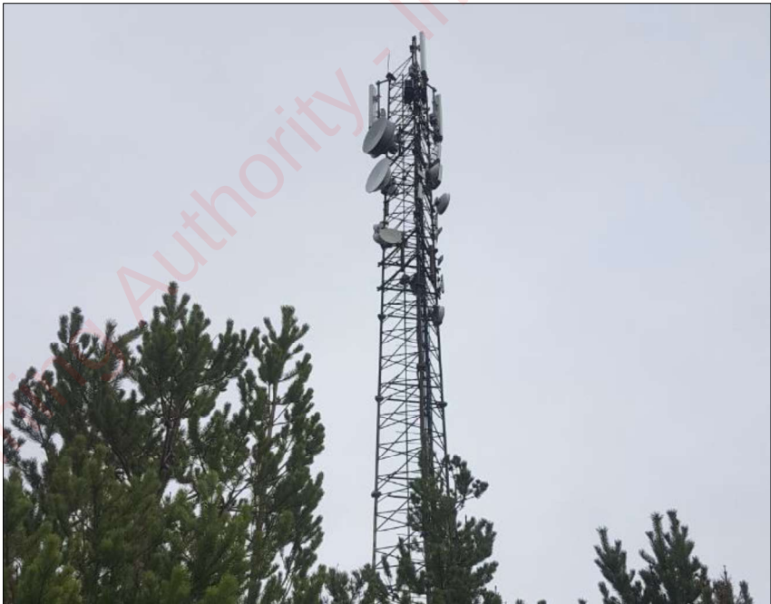
Figure 9.7. Shanettra - Mast A3
